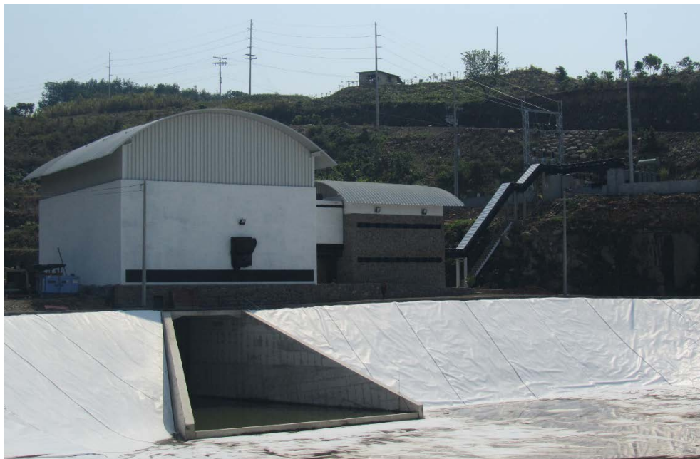
Figura n° 4: Vista de la fachada suroeste y noroeste de casa de máquinas y edificio de control.
