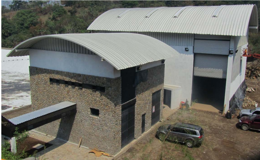
Figura n° 5: Vista de la fachada sureste y noreste de casa de máquinas y edificio de control.
