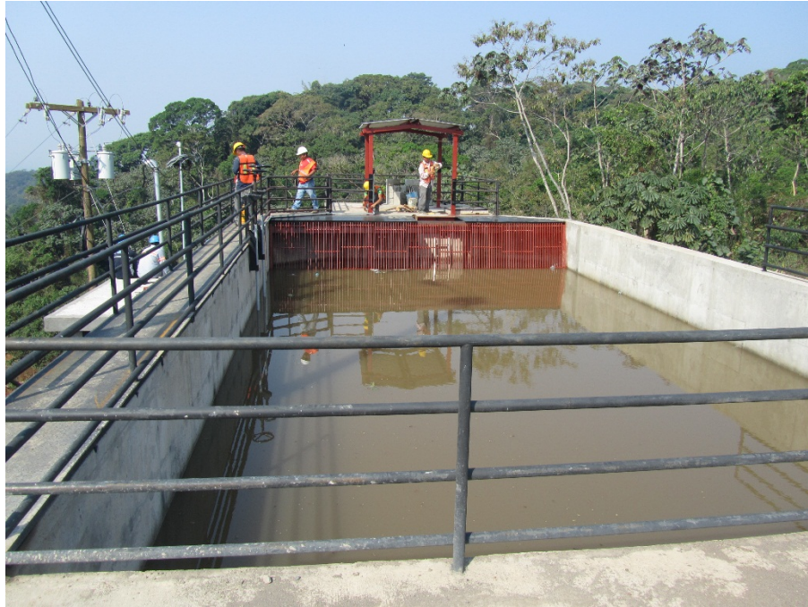
Figura nº 3: Balsa de regulación. Vista del desarenador y reja.
