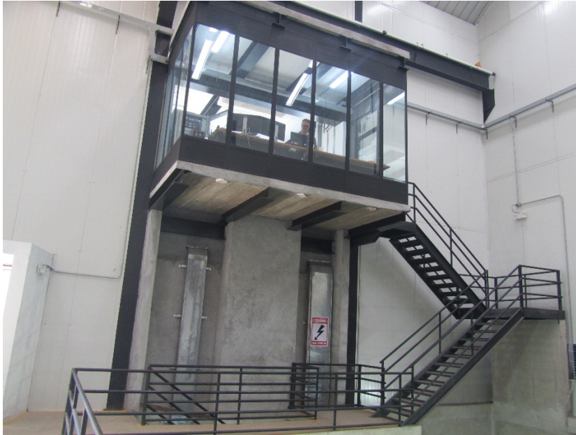
Figura n° 9: Vista de la escalera que comunica la explanada con la sala de control.
