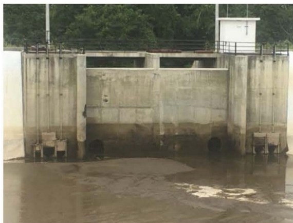
Figura n° 15: Balsa de desregulación. Vista de los desagües al río Ocosito.
