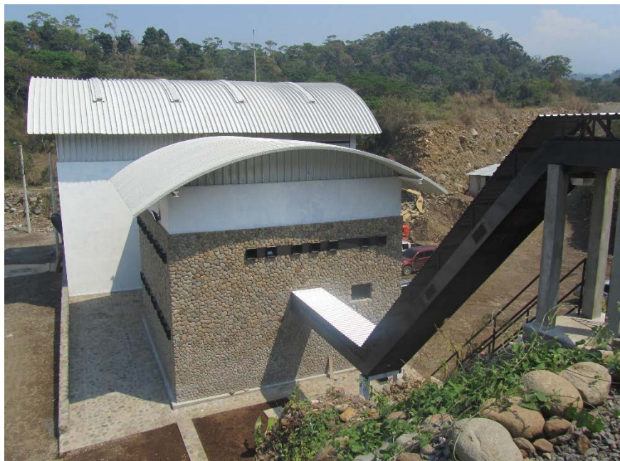
Figura n° 6: Vista de la fachada sureste de casa de máquinas y edificio de control.
