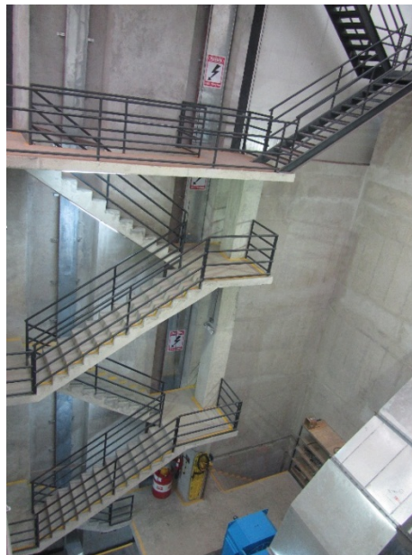
Figura n° 8: Vista de la escalera se comunica el foso de turbinas y la explanada.
