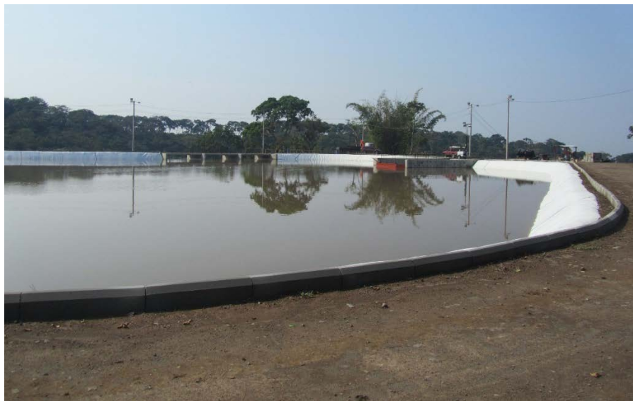
Figura n° 2: Balsa de regulación. Vista del aliviadero de seguridad y desarenador.
