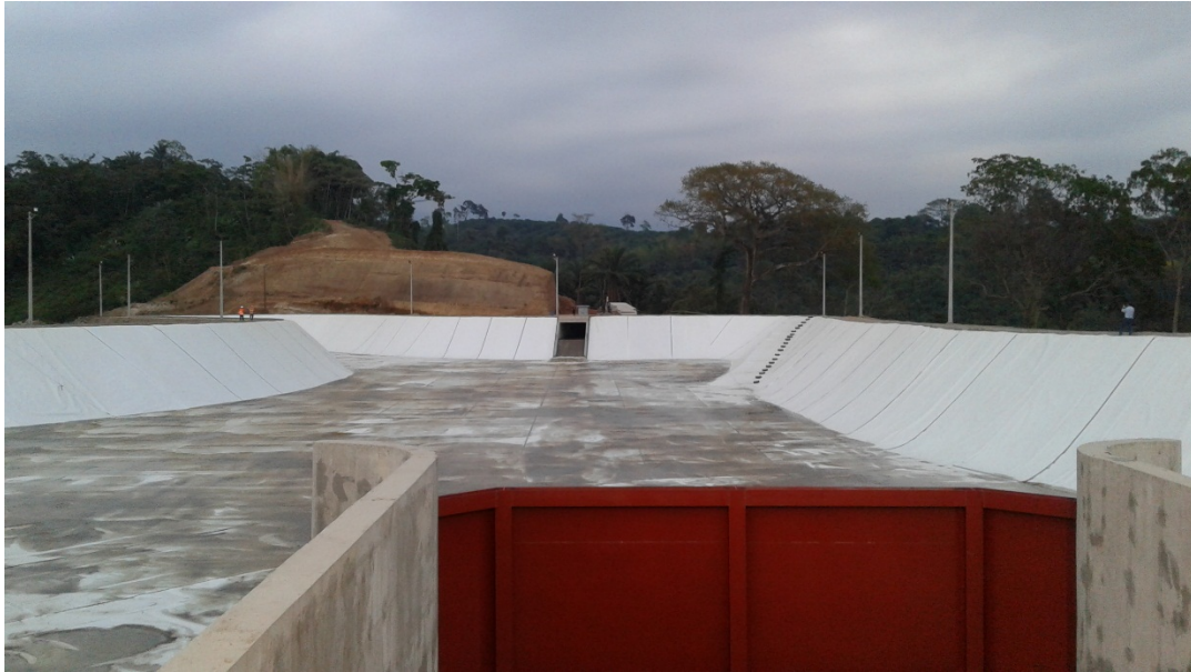
Figura n° 1: Balsa de regulación. Vista desde el desarenador. Detalle del deflector y obra de llegada del canal.
