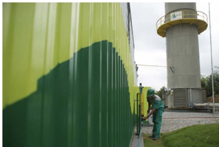
Landfill Gas Collection
