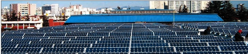
대구가 10억 원을 들여 지난달 완공한 두류정수장에 있는 태양광 발전시설. 이 시설은 하루 80KW의 전기를 생산할 수 있다. 대구시는 솔라시티를 지향하고 있다. 사진제공 대구시
