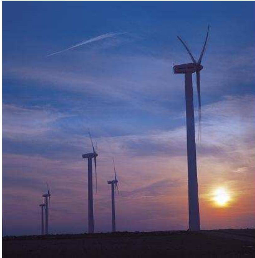
< 3.3> 850kW 풍력발전시스템 전경
