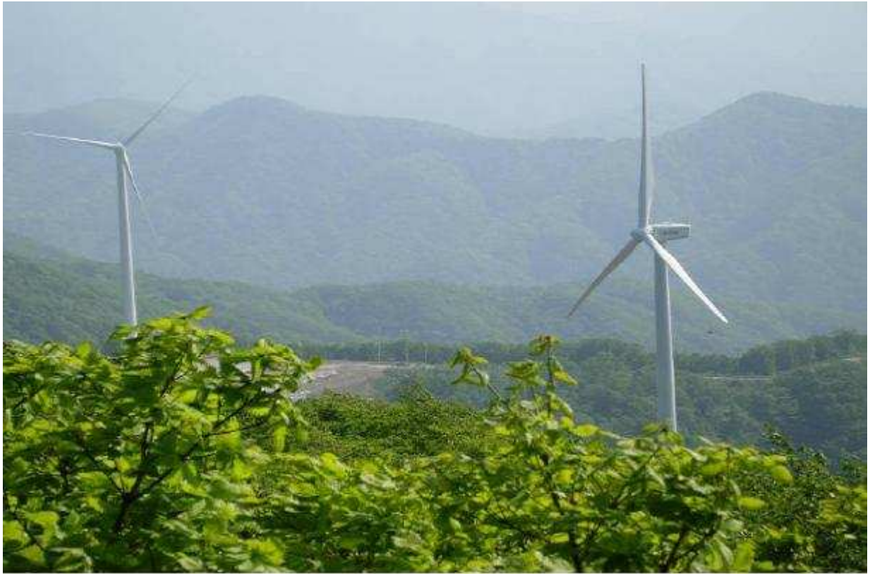
< 3.1> 1,500kW 풍력발전시스템 전경
