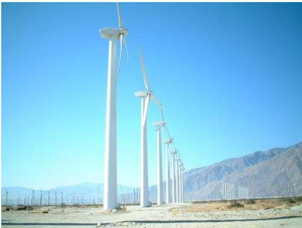
< 3.2> 1,000kW 풍력발전시스템 전경
