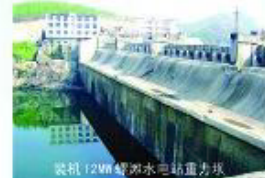
装机12MW峡山水电站重力坝
